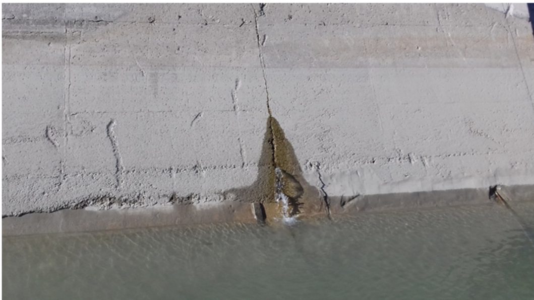
Fig. 4– Manufatto Limitatore di Monte- Filtrazione d’acqua tra i giunti
